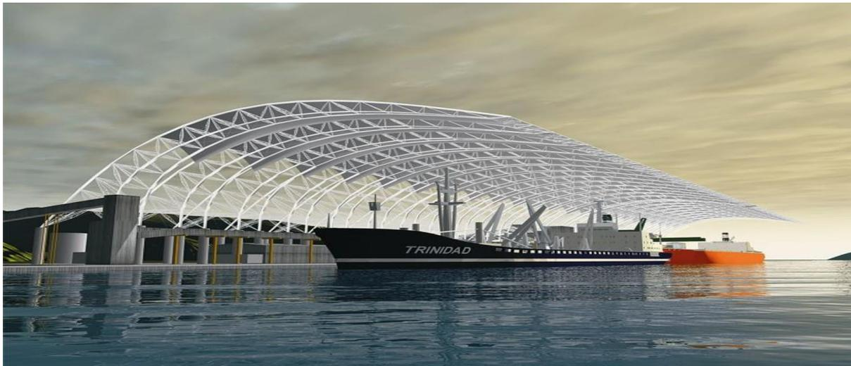
"O modelo fixo é uma cobertura metálica que custa R\$ 70 milhões e lembra a marquise de um estádio de futebol. Será instalada no berço de atracação do terminal sul da Rumo, com 138 metros de comprimento por 76 metros de altura, suportando inclinação de chuvas de até 41 graus. "É uma cobertura adequada para os maiores navios cargueiros usados no embarque de açúcar, embarcações com capacidade entre 80 mil e 120 mil toneladas", diz Fontana Neto.
